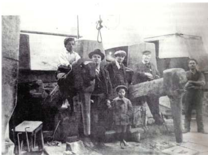
Fonderia di Rame detta "Il Maglio Vecchio" di Villa Scirca di Costacciaro
