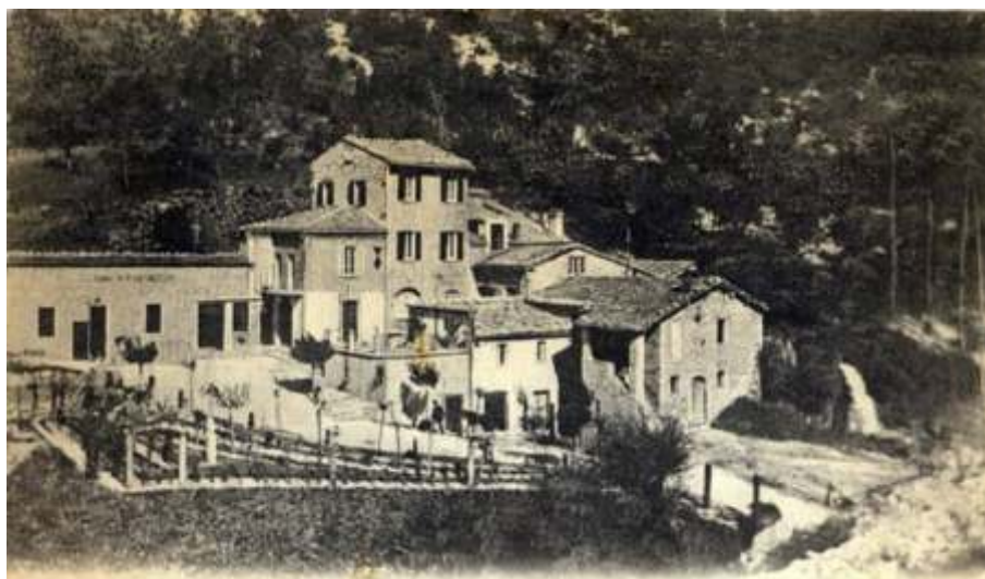
Fonderia di Rame detta "Il Maglio Nuovo" di Villa Scirca di Costacciaro
